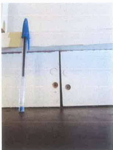
Figura 43 – Falta de acabamento e danos nas peças do rodapé.
