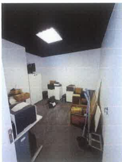
Figura 58 – Divergência quanto ao local previsto para instalação de porta do ambiente ARQUIVO.
