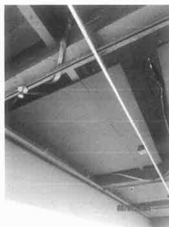
Figura 66 – Divergência teto ambiente FOYER / EXPOSIÇÕES.
