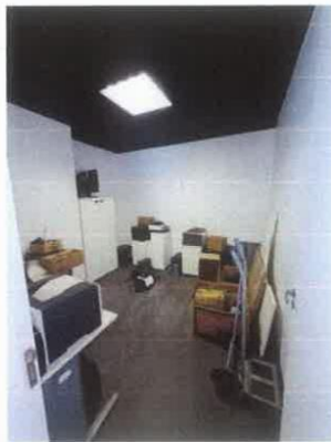
Figura 58 – Divergência quanto ao local previsto para instalação de porta do ambiente ARQUIVO.
