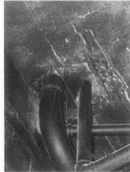
Figura 64 – Divergência teto ambiente DEPÓSITO.
