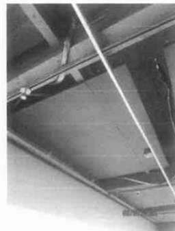
Figura 66 – Divergência teto ambiente FOYER / EXPOSIÇÕES.
