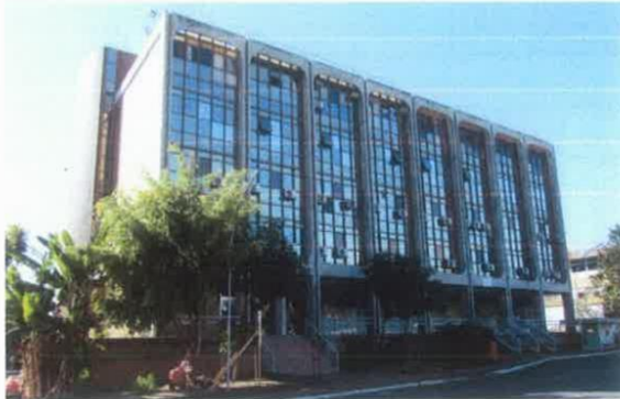
Figura 1 – Edifício Comercial localizado na SCLN 510 Bloco A Lote 06 – Asa Norte – Brasília / DF.
